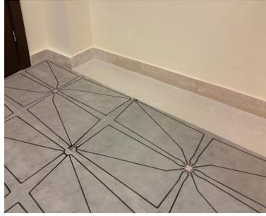
Figura 3.20: Instalación de SensFloor
