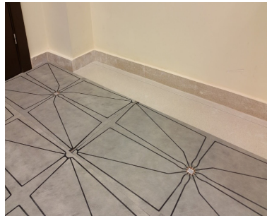
Figura 2.16: Instalación de SensFloor
